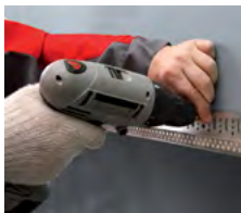
Рис. 7.20. Установка стартового профиля
