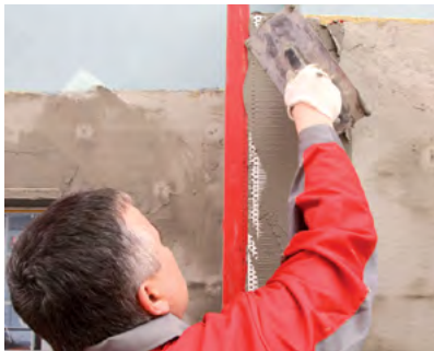
Рис. 7.30. Армирование базового штукатурного слоя стеклосеткой
