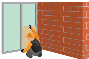
Рис. 6.5. Укладка плит ТЕХНОАКУСТИК
