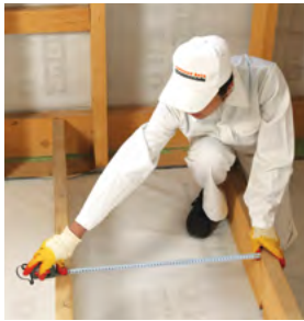
Рис. 4.11. Смонтированная пароизоляционная пленка
