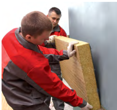
Рис. 7.24. Приклейка теплоизоляции
