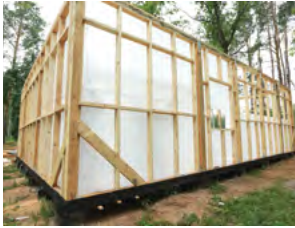
Рис. 7.15. Монтаж пароизоляционной пленки
