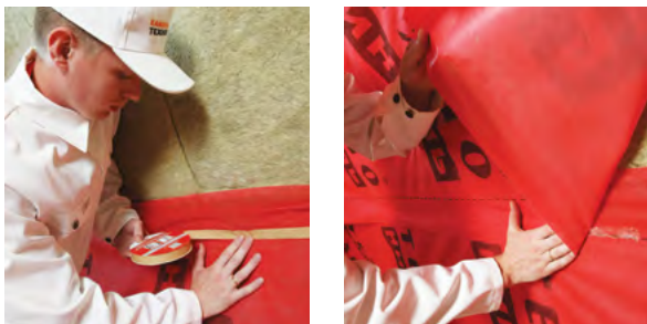
Рис. 4.7. Проклейка стыков пароизоляционной пленки
