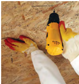
Рис. 4.12. Подшивка потолка листами ОСП
