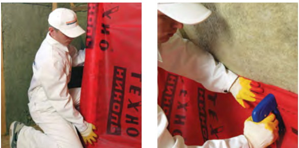
Рис. 4.6. Укладка и фиксация пароизоляционной пленки
