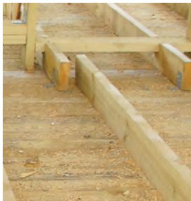
Рис. 5.2. Подшивка лаг снизу
