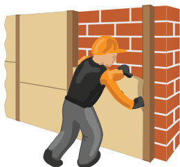
Рис. 7.3. Монтаж теплоизоляционных плит в вертикальный каркас
