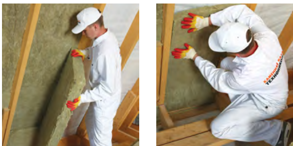
Рис. 4.4. Монтаж теплоизоляции в распор между стропилами
