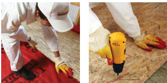
Рис. 5.5. Монтаж листов ОСП чернового пола
