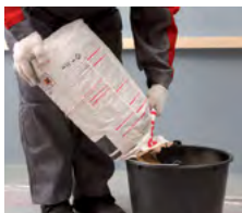
Рис. 7.21. Процесс приготовления клея
