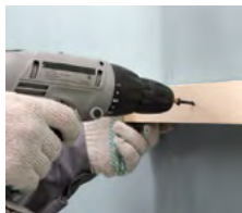
Рис. 7.20. Установка стартового профиля
