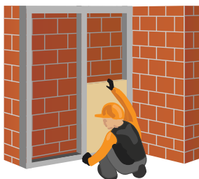
Рис. 6.10. Монтаж теплоизоляционных плит
