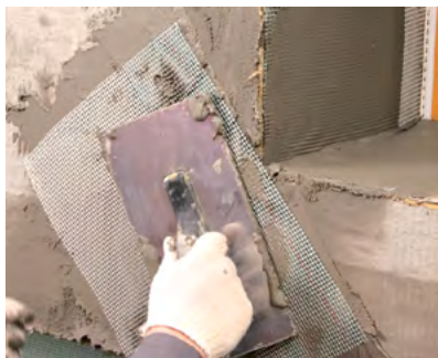
Рис. 7.28. Процесс усиления угла проема элементом из стеклотсетки
