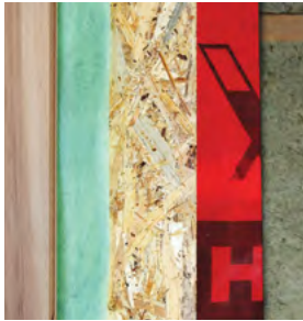
Рис. 5.6. Слои системы пола по лагам
