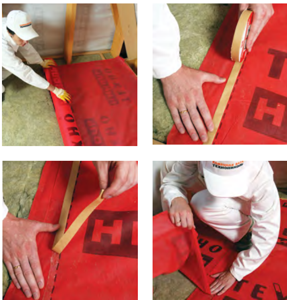
Рис. 5.4. Монтаж пароизоляционной пленки
