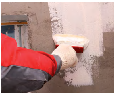
Рис. 7.31. Грунтовка поверхности
