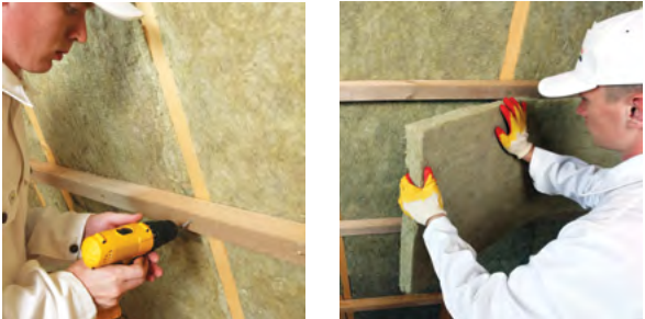
Рис. 4.5. Укладка второго слоя теплоизоляции
