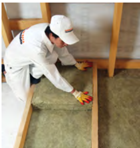
Рис. 5.3. Монтаж теплоизоляции в распор между лагами
