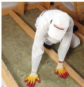
Рис. 4.13. Монтаж теплоизоляции между балками
