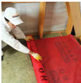
Рис. 4.14. Монтаж ветро-влагозащитной пленки
