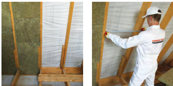
Рис. 4.3. Подготовленная система для дальнейшего монтажа теплоизоляции
