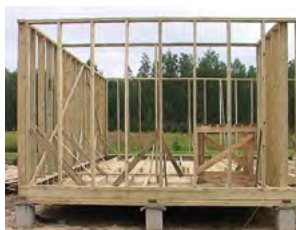
Рис. 7.14. Готовый деревянный каркас
