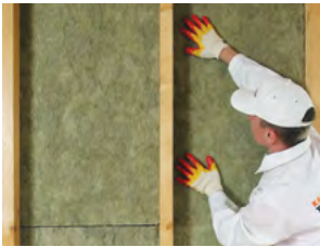
Рис. 7.16. Монтаж теплоизоляционных плит
